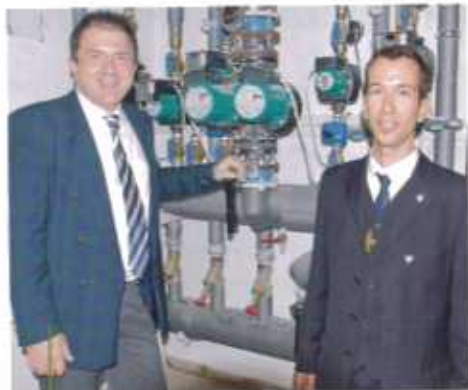
Johannes Motz sah sich bei der Einweihung die Heizungsanlage an.
